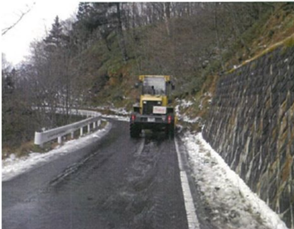
林道勘行峰線除雪状況
