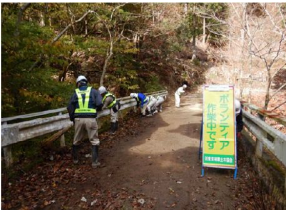
橋梁上部清掃状況
