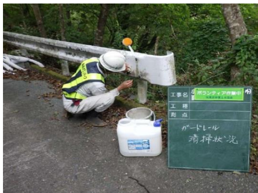
ガードレール清掃
