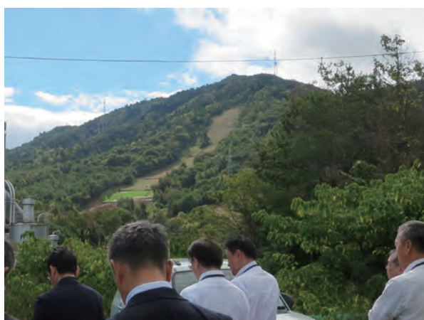
(山腹復旧状況全景)
